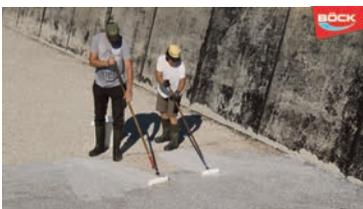
Die angerührte Grundierung wird nun mit einer Farbwalze satt und gleichmäßig auf die Silofläche aufgetragen. Anschließend ist eine Trocknungszeit von 2-4 Stunden einzuplanen.
