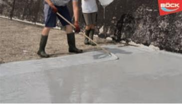
Nun wird die Verlaufsmaße auf die vorgrundierte Fläche aufgetragen und gleichmäßig verteilt. Dazu wird ein Gummischieber verwendet.
