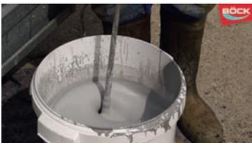
Nach der Trocknung wird die Verlaufsmasse aus **BÖCK-Bodenfix 2K (8,5 kg)**, **BÖCK-Füllstoffmischung (20 kg)** und Wasser (0,5 l) angemischt.
