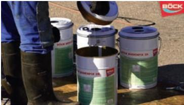
Nun wird eine Grundierung aus dem **BÖCK-Bodenfix 2K** angerührt. Hierzu durchstößt man den oberen Deckel, öffnet die Dose und führt so die beiden Komponenten zusammen. Dann rührt man die Masse gründlich auf. Anschließend topft man die Flüssigkeit um. Nochmals rühren und mit rund 50% Wasser verdünnen.
