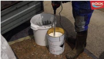
**TIPP"** Die Grundierung kann auch auf feuchten Untergründen eingesetzt werden! Wasserzugabe bei 8,5 kg Gebinde: 5 Liter
