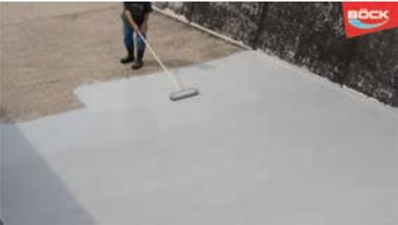
Sofort nach dem Verteilen der Verlaufsmaße muss die Verlaufsmaße mit einer **Stachelwalze** entlüftet werden, um Luftschlüsse zu vermeiden.
