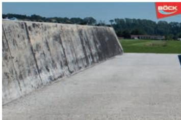
Der zu sanierende Untergrund muss sorgfältig gereinigt werden (hier empfiehlt bei größeren Flächen Kugelstrahlen). Sämtliche Verschmutzungen müssen entfernt werden, bis das Korn im Beton zum Vorschein kommt.
